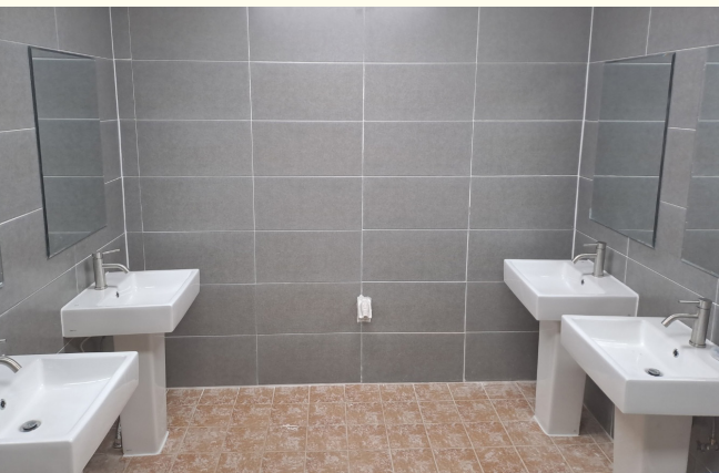
보수공사를 거쳐 새롭게 단장된 일립생활관 1층 화장실 모습
